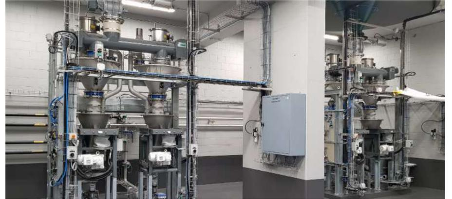
Dazu wurde die Verfahrenskombination mit der Dosierung von Pulveraktivkohle (PAK) auf die Filtrationsstufe mit der Möglichkeit der direkten Dosierung in die biologische Stufe als die geeignetste Verfahrensvariante gewählt.
