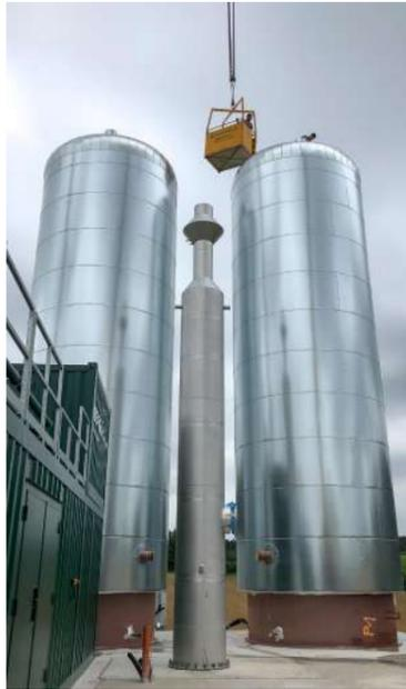
Die Anfang des Jahres von SÜLZLE KOPF gelieferten Pufferspeicher für die „Bioenergie Sulz“ mit je 150 m<sup>3</sup> Wasserinhalt wurden am 23. August 2019 aufgestellt und bildeten für SÜLZLE KOPF Gebäudetechnik den Startschuss für die Einbindung eines neuen Biogas BHKW Jenbacher mit einer elektrischen Leistung von mehr als 1 MW. Das BHKW-Modul wurde bauseits zur Verfügung gestellt.
