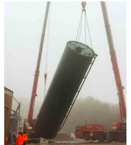
SÜLZLE KOPF hat auf der Kläranlage in Gre- ven die Dosieranlage für Pulveraktivkohle (AK-DOS®), bestehend aus Silo, Austrags- und Fördersystem, Dosiereinrichtungen, Dosierleitungen und der dazugehörigen Schalt- und Steueranlage geliefert, montiert und in Betrieb genommen.
